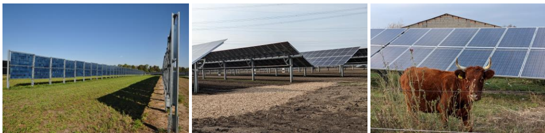
Abbildung 7: Beispiele für Agri-PV – Ackerbau mit vertikalen Modulen (links) und mit nachgeführten Modulen (Mitte), Agri-PV mit Tierhaltung (rechts)
